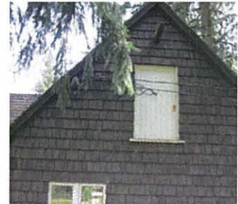
West elevation hay loft door
